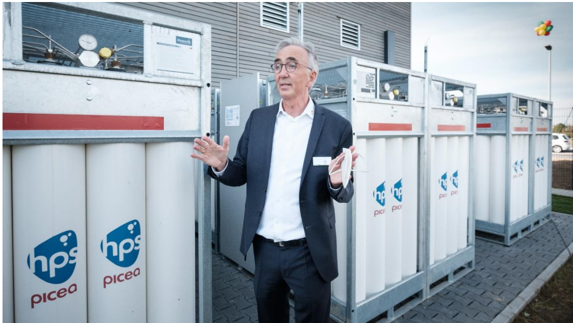
Geschäftsführer Peter Küpper demonstriert den Wasserstoffspeicher, in dem 440 kg H 2 selbst erzeugter grüner Wasserstoff eingelagert ist
