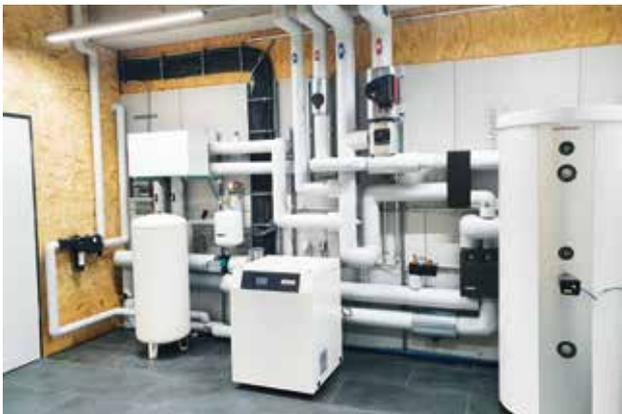
**Erdwärmepumpe zum Heizen und Kühlen, mit 17,5 kW Heizleistung**
