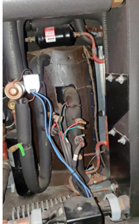
Abb. 6: Innenansicht der Luft-Wasser-Wärmepumpe.
