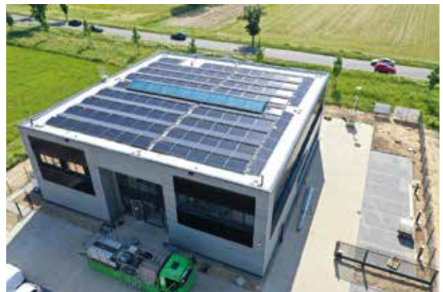
Solarstromanlage mit 98 kWp Leistung
