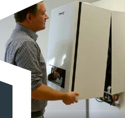
Das Kit 65 wird beim Kesseltausch unkompliziert an die vorhandenen Anschlussstellen montiert. Jetzt sind Hydraulik und Regelung bereit für die spätere Anbindung der Wärmepumpe.
